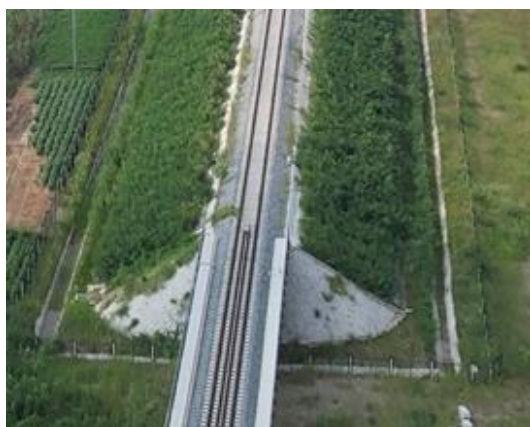
桥梁锥体防护
