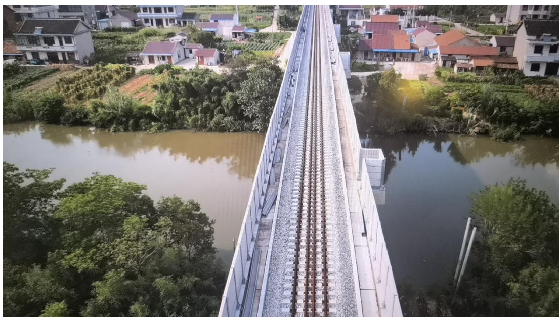
工程跨越海门河清水通道维护区现状
