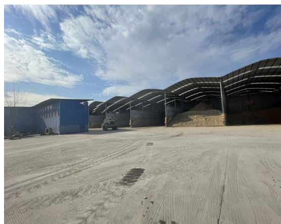
拌合站封闭料仓
