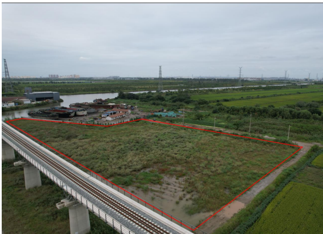
2#拌合站恢复情况
