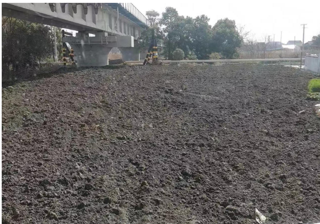
施工便道恢复情况
