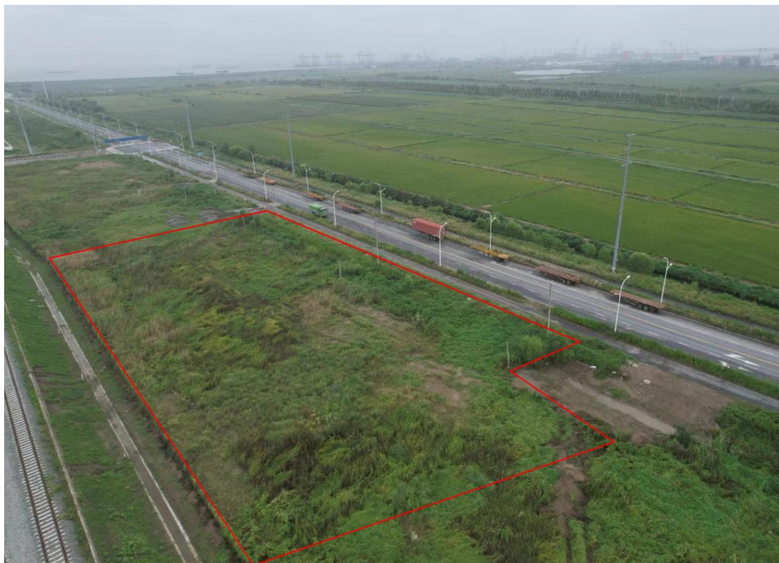
1#小型预制构件场恢复情况
