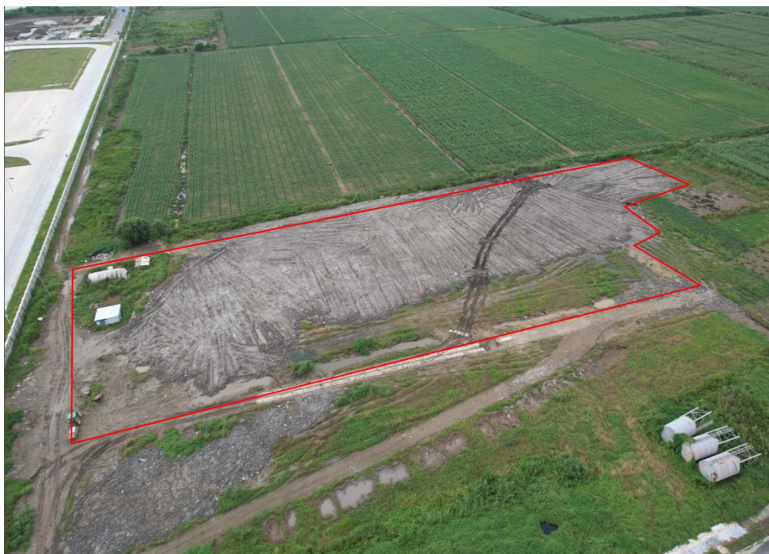
3#拌合站恢复情况
