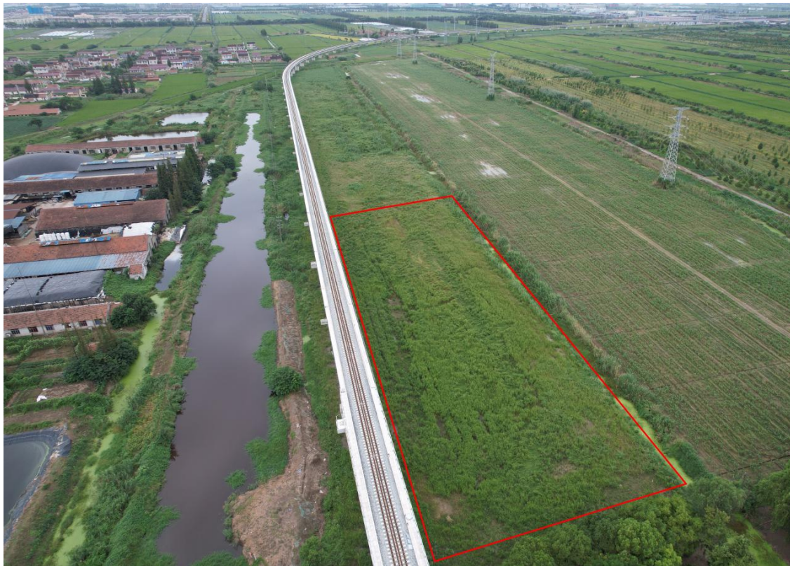
1#钢筋加工场恢复情况
