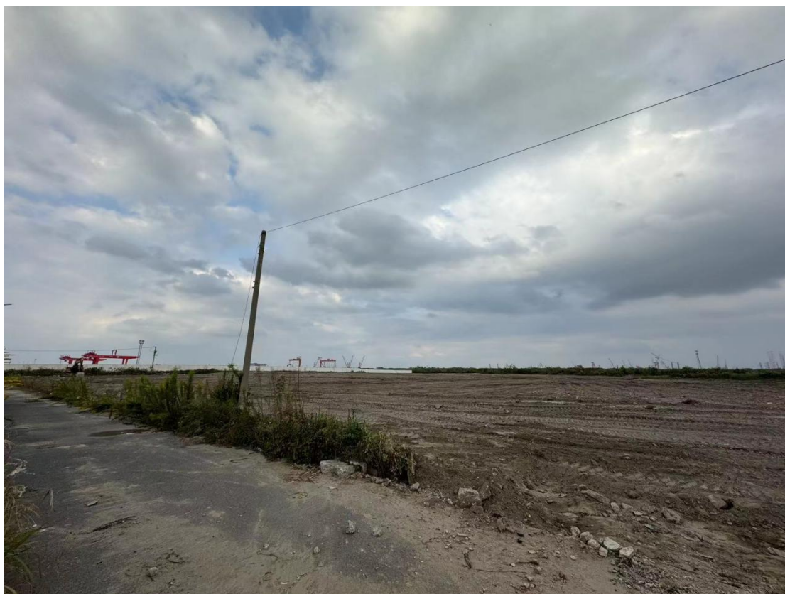
1#制梁场恢复情况
