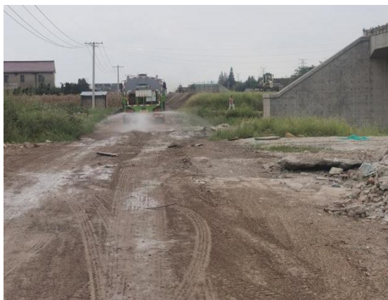
施工便道洒水抑尘
