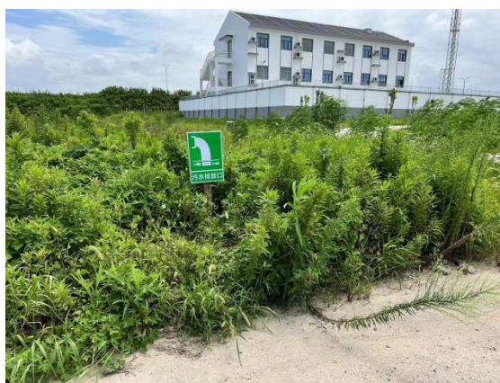
通海港站排污口标志
