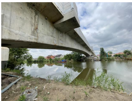
跨河桥梁未设水中墩
