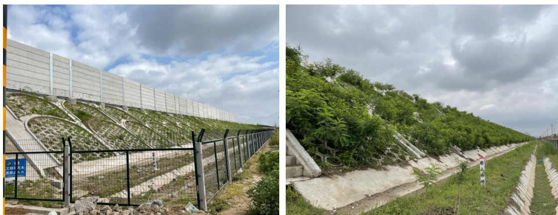
路基边坡防护、排水沟、绿化措施
