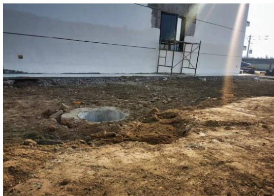
海门站化粪池
