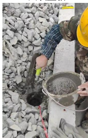
桥面泄水孔封堵
