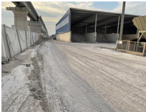
拌合站厂界围挡
