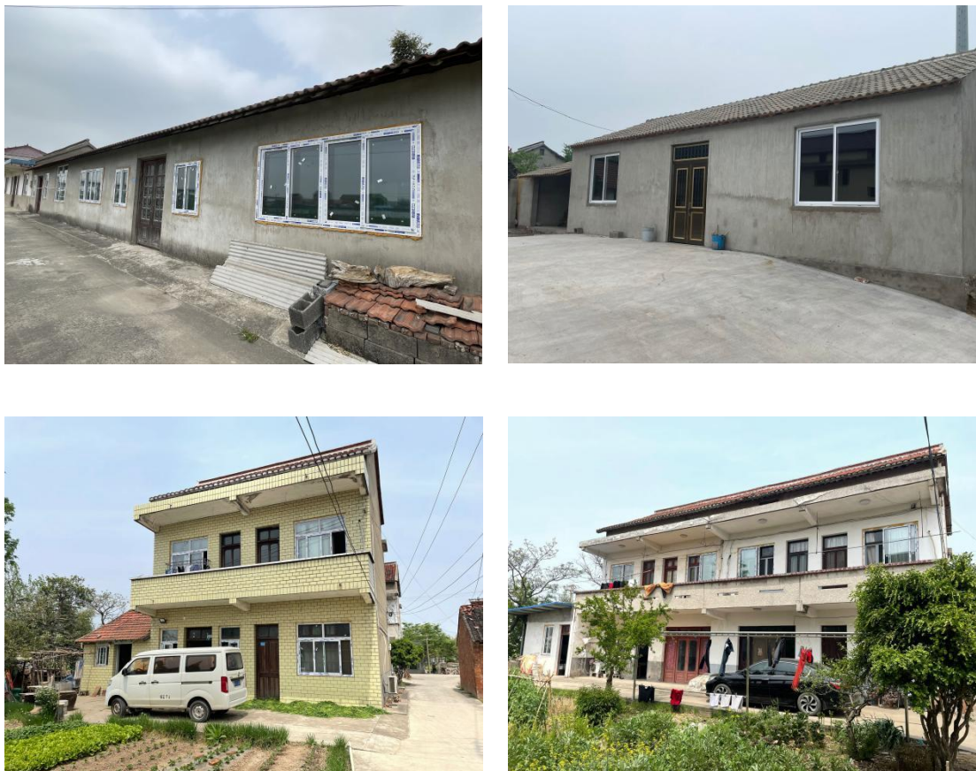
部分隔声窗安装情况
